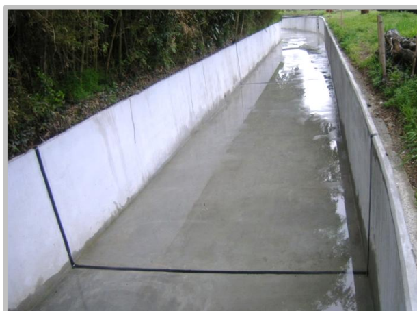
施工完了 (ASモルタル工法との併用)
