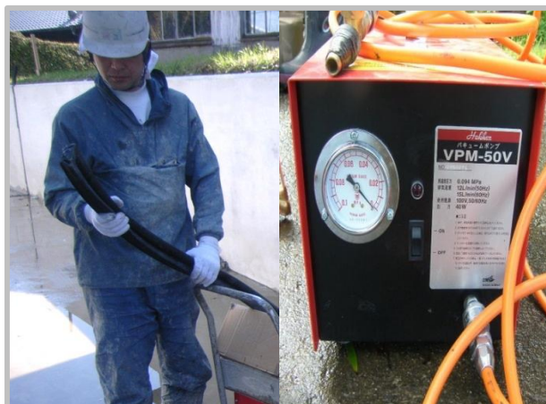
目地材吸引工(右: 吸引ポンプ) (吸引ポンプによる目地材内空気の吸引)
