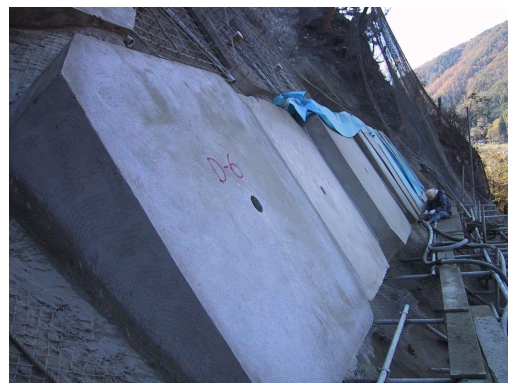
解説写真 4.2 ざぶとんわく完成状況
