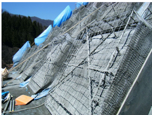
解説写真 4.1 吹付けモルタル打設状況
