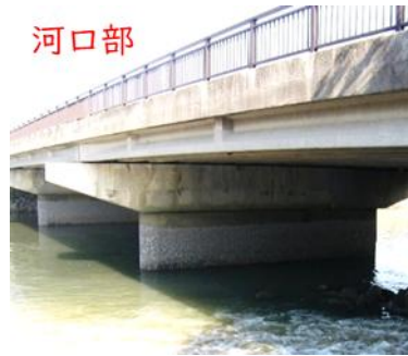
河口部 既設床版下面・地覆の塩害対策
