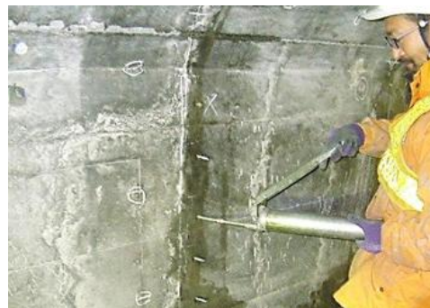
漏水補修(高圧注入)状況：水路トンネル
