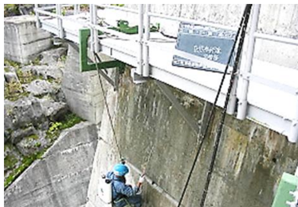
ダム堤体下流面: CS-2Ⅰ噴霧状況
