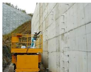
ひび割れ補修：橋台
