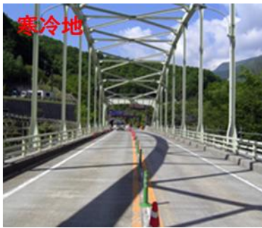
寒冷地 既設床版(コンクリート舗装)の凍害対策
