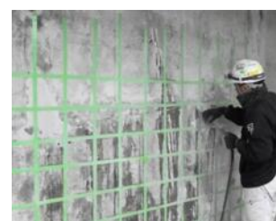
漏水補修：地下室
