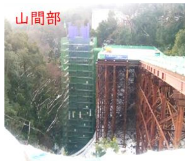
山間部 新設橋脚の凍害・中性化対策
