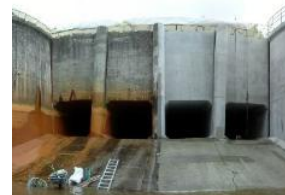
吐水槽壁・樋管坑口
