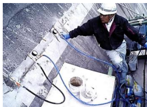
漏水補修（高圧注入）状況：ダム
