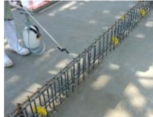
打継ぎ部処理：水平
