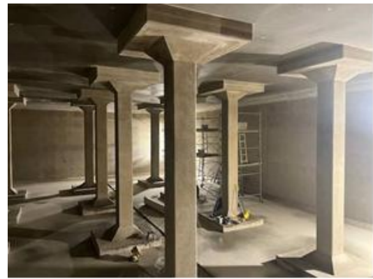
水槽防水（既設：既存塗膜除去後、CS-21 塗布）
