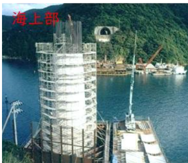
海上部 新設橋脚の塩害対策
