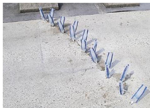
漏水補修(低圧注入)状況：駐車場
