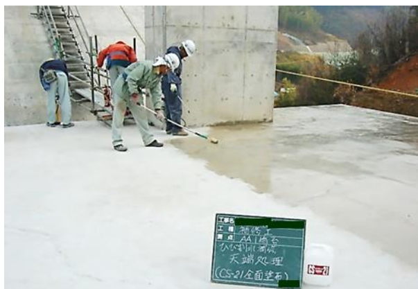
橋台上面: CS-2Ⅰ塗布状況
