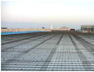
① 鉄筋検査 ▶
