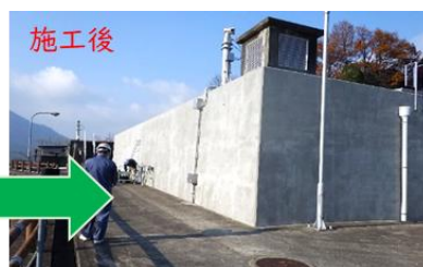
既設浄水池（水道施設）外壁の長寿命化＋美観回復対策
