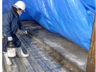
打継ぎ部処理：鉛直
