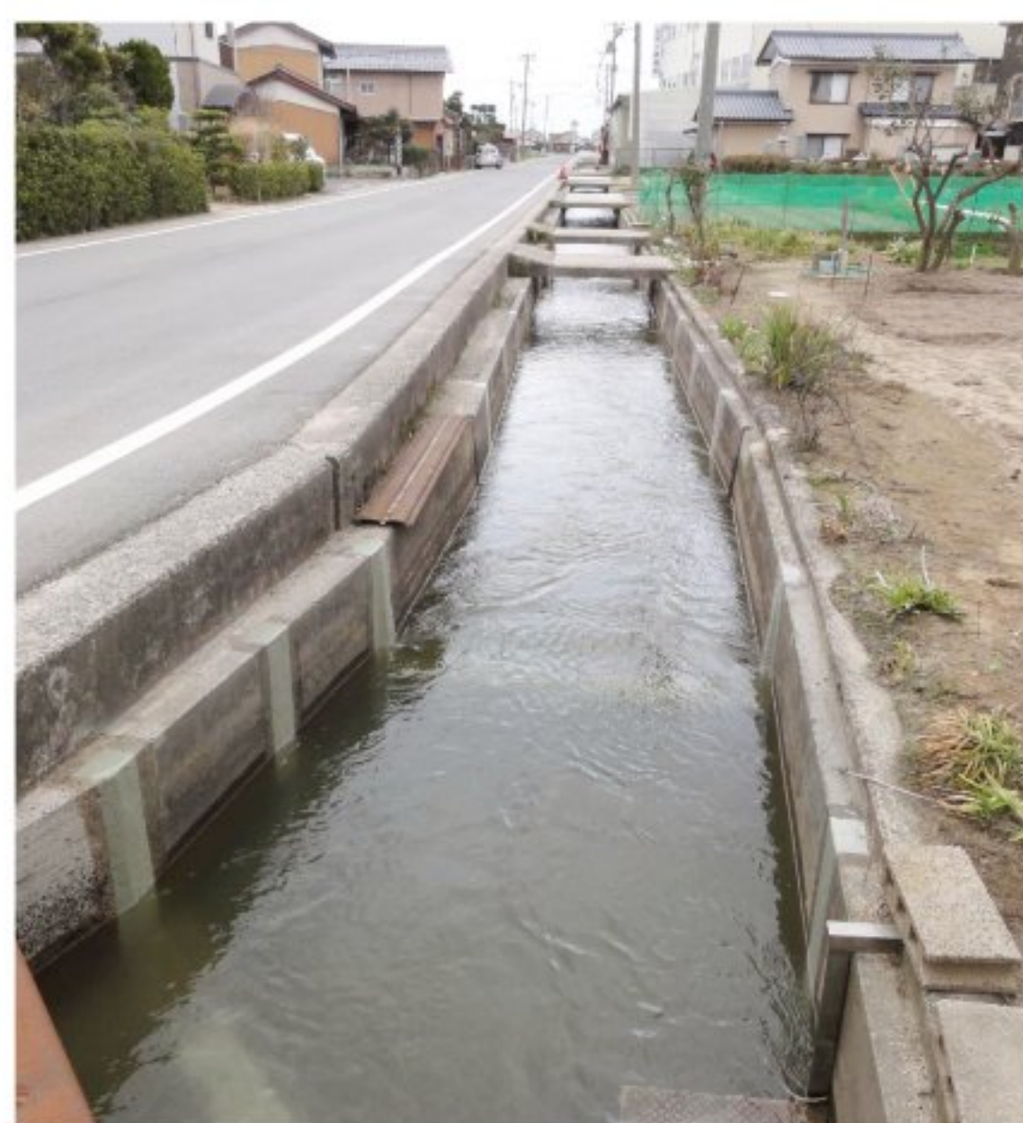
大型フリーダム目地補修
