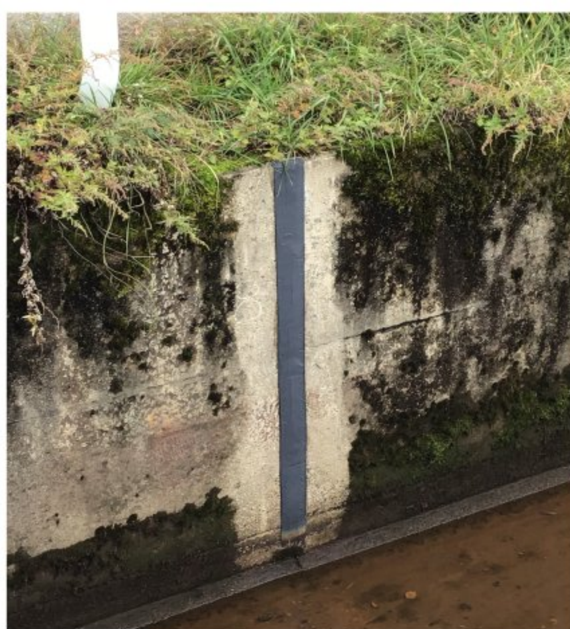
現場打ち水路（黒色）
