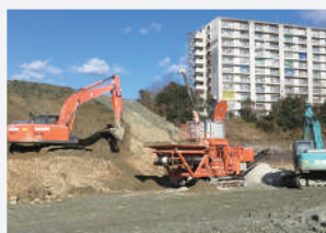
残土処分せず工区内利用
