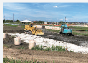
農地・水辺周辺の工事に
