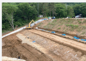
改良土を堤体盛土に使用
