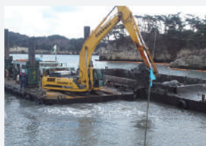
港湾浚渫土を良質改良土へ
