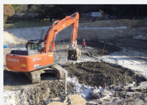
ため池工事池底改良
