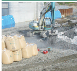
バックホウによる原位置改良
