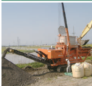
自走式改良機による発生土改良
