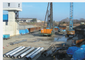
杭打ち重機足場改良
