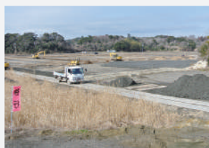
圃場嵩上げ工事に再利用
