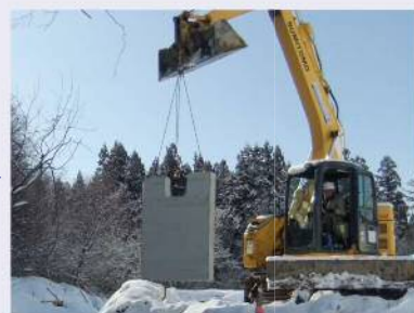
2. 呑み口隔壁部据付
