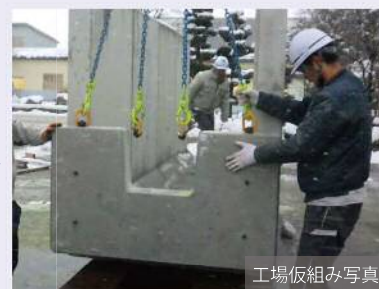
3. 吐け口隔壁部据付
