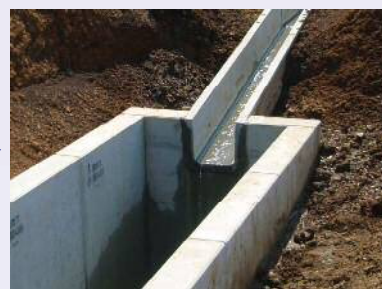
5. 排水フリューム据付
