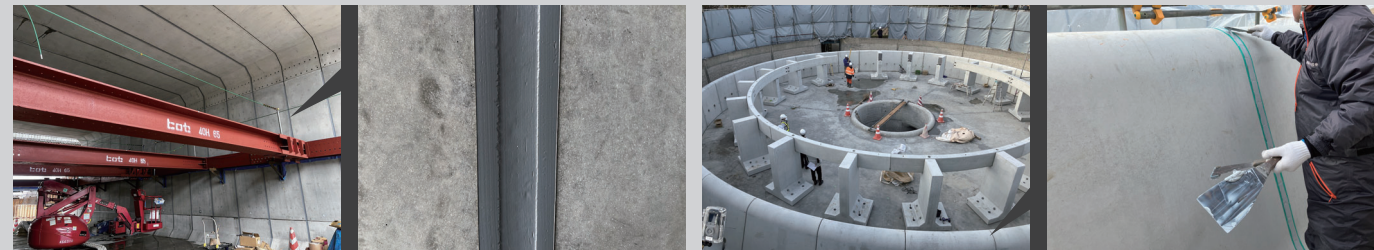
施工地：千葉県 製品種類：2分割ボックスカルバート（B8500×H5500）
