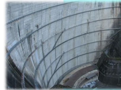
ダム壁面調査
