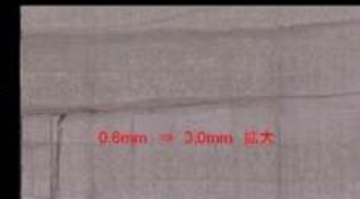
変形モードコンター、ひび割れ・うき等の検出事例
