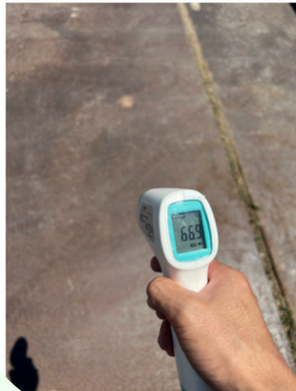
【表面から約 1.6 メートル】左：敷鉄板、右：CLT 敷板
