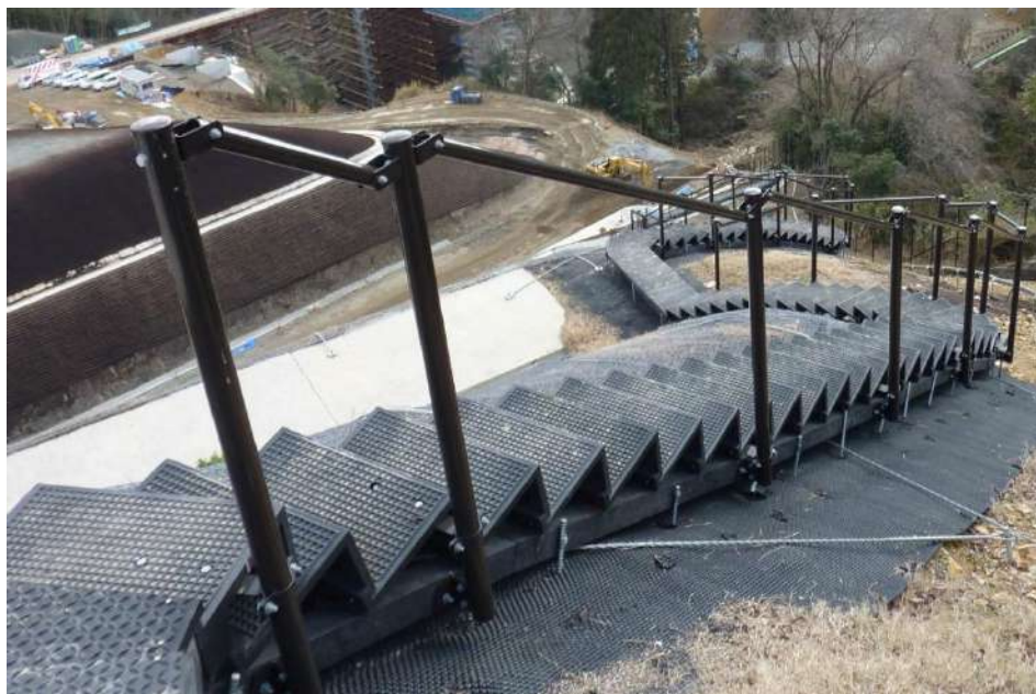
硬い地山取付階段と 本体取付手摺
