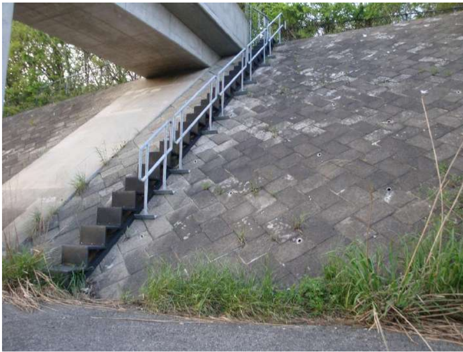
コンクリート面取付例 (橋梁脇コンクリートブロック)
