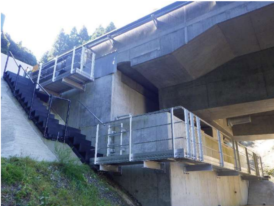
橋梁階段 (下地: シールコンクリート)
