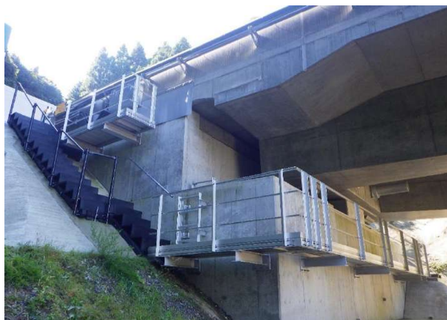
橋梁階段 (下地: シールコンクリート)
