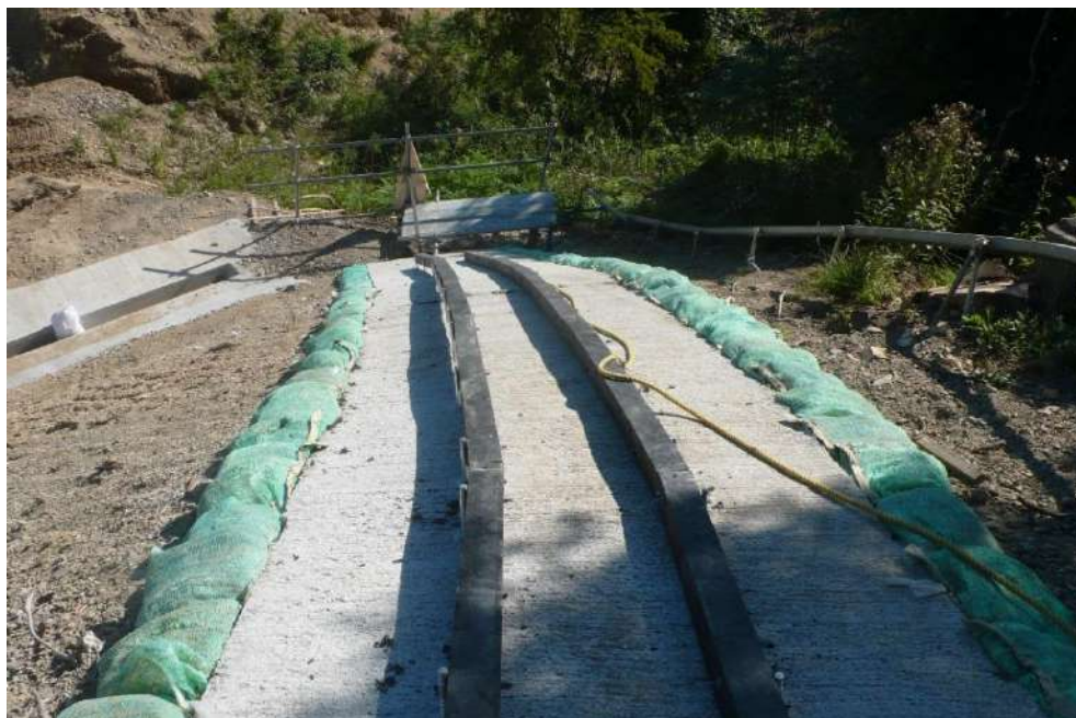
シールコンクリート面 特殊施工例
