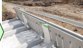
吸出し防止材設置
