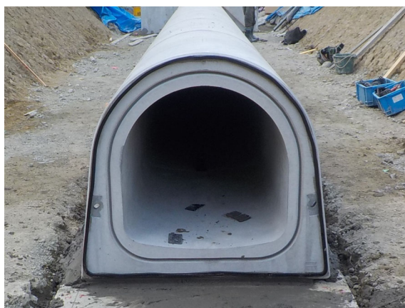
写真 2.5-1 小口面パッキン材貼付
