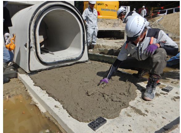
写真 2.4-4 CB モルタル設置状況
