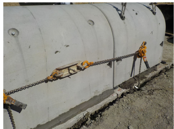
写真 2.5-4 製品引き寄せ作業
