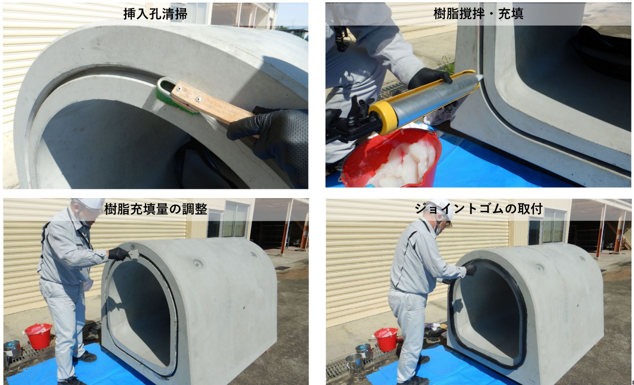
写真 2.5-2 TSKJ 工法による継目処理
