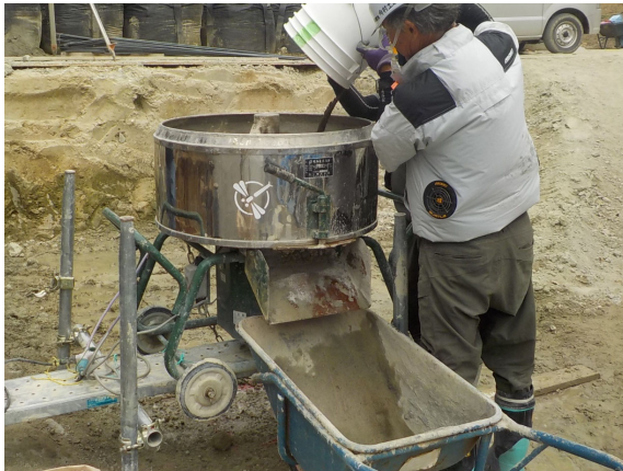
写真 2.4-3 CB モルタル練り状況
