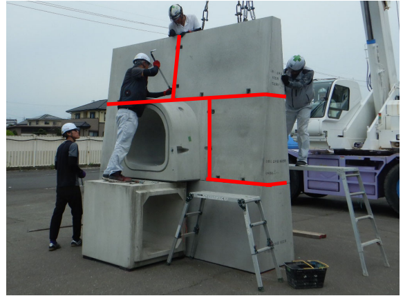
写真 2.4-2 弾性シーリング材充填
