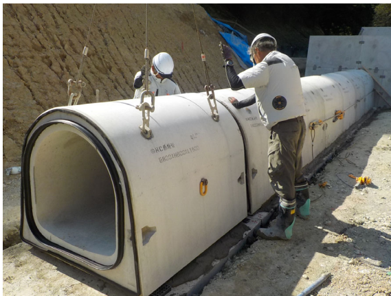
写真 2.4-5 MC 底樋管据え付け
