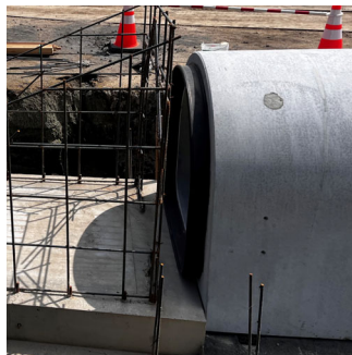
図 2.5-6 片側止水板対応型の TSKJ 止水板対応例
