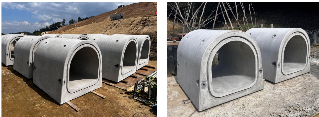
写真 2.1-1 MC 底樋管の仮置き状況事例
