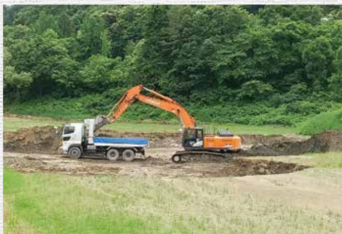
ダンプトラック積込み
