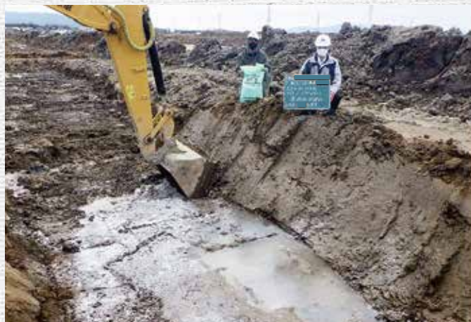
混合状況確認
