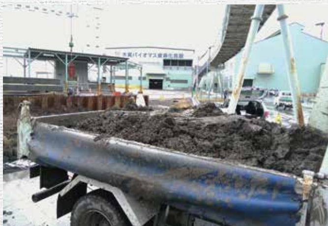
ダンプトラック積み込み
