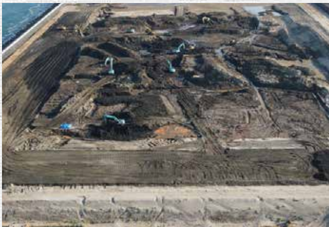
着工時現場全景
