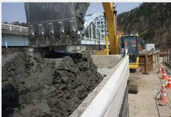
ダンプトラック積み込み
