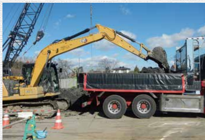
ダンプトラック積込み
