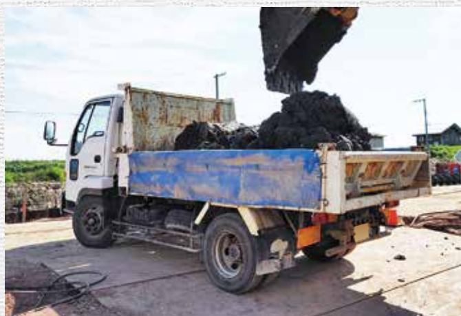
ダンプトラック積み込み
