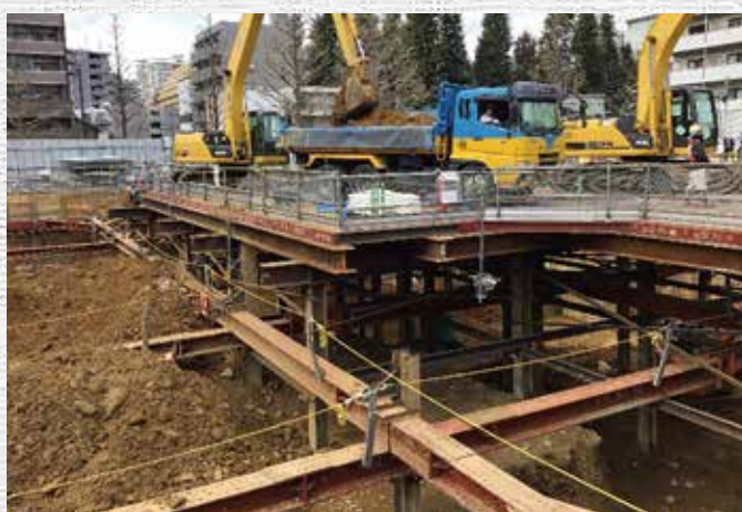
ダンプトラック積み込み
