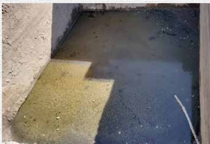
排水処理後の状態
