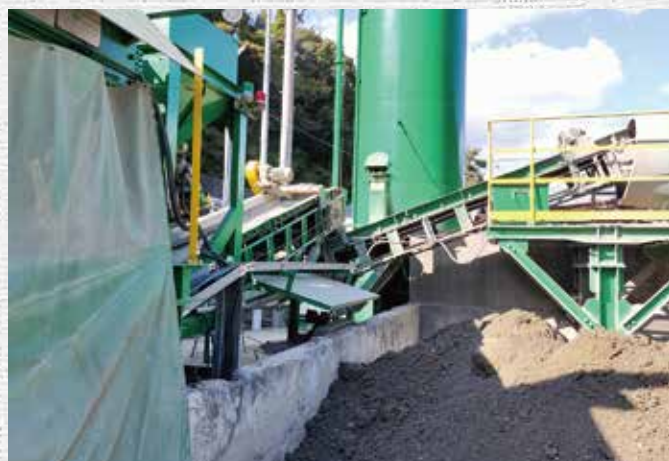
プラント稼働状況①
