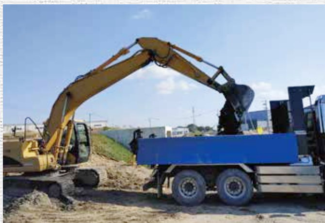
ダンプトラック積み込み
