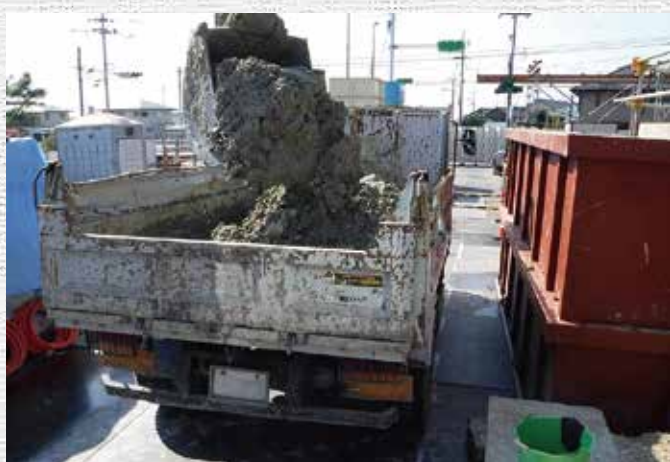
ダンプトラック積み込み
