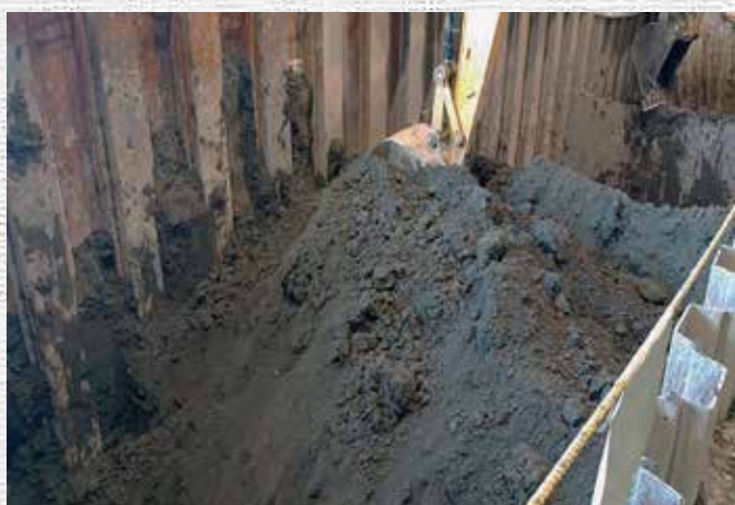
3時間養生後の状態
