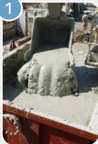
高含水泥土発生
