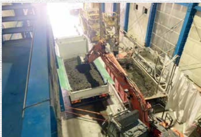
ダンプトラック積込み
