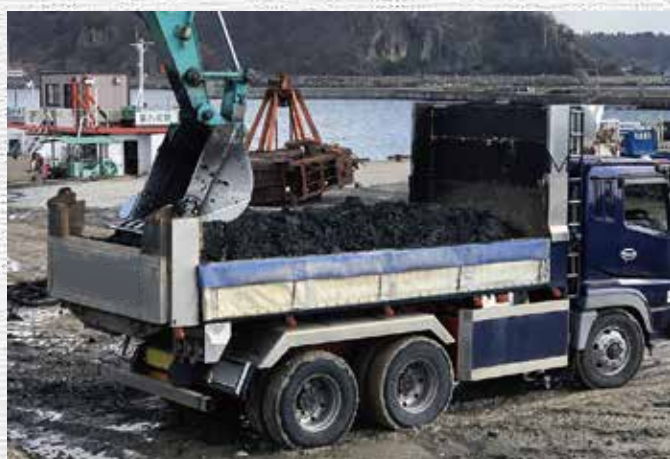
ダンプトラック積み込み
