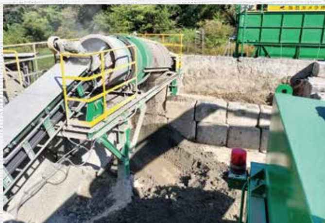
プラント稼働状況②
