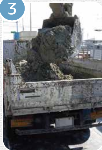
ダンプトラック積み込み
