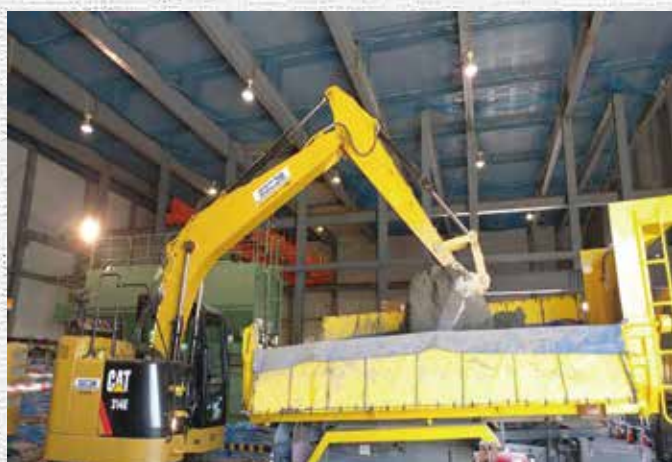
ダンプトラック積み込み
