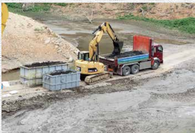
ダンプトラック積込み
