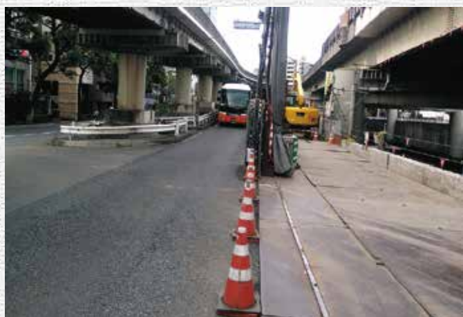
狭小な現場状況
