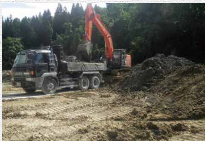
ダンプトラック積み込み
