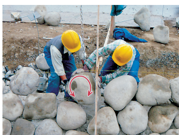
専用吊具使用・製品据付
