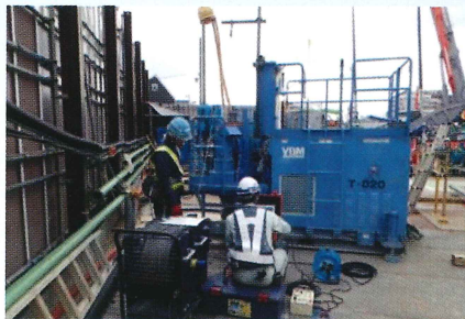
削孔精度確認状況
