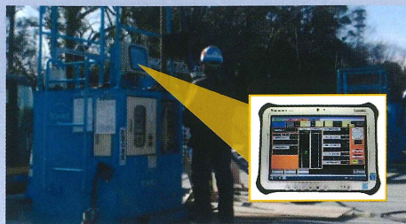
実現場での施工管理状況
