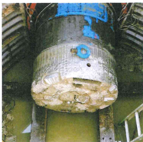
写真－7 掘進機到達状況
