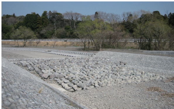
国土交通省 大井川 2t型 施工時
