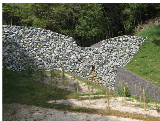
施工後 環境省 加太園地（和歌山県）
