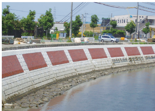
諏訪川(レンガ仕様)（福岡県）
