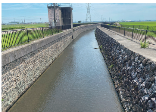
中井筋(明治用水路)（愛知県）
