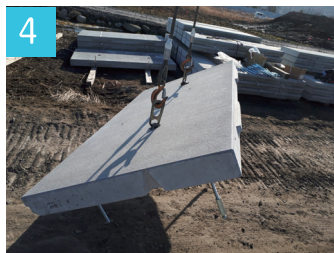
4 アンカー取付け後
