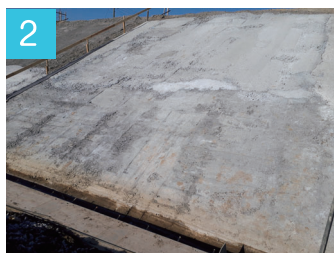
2 均しコンクリート打設
