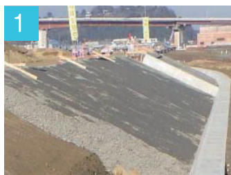
1 法面整形・基礎砕石転圧
