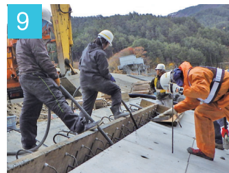
9 コンクリート締固め
