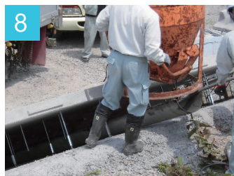
8 胴込コンクリート打設
