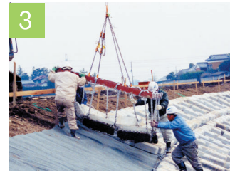
ブロックネット敷設
