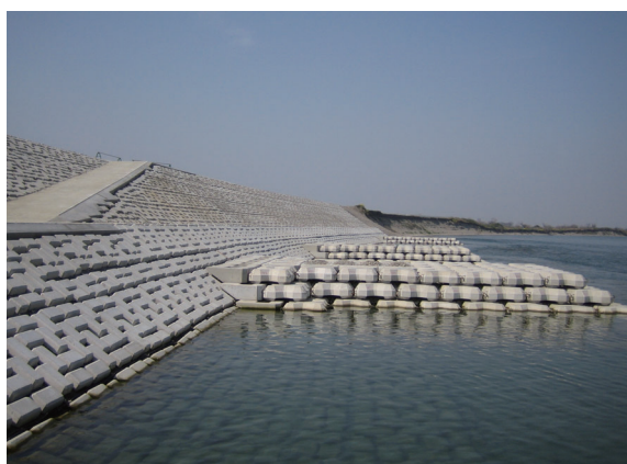
国土交通省 吉野川 コンクリート標準タイプ200型
