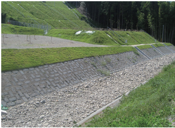
NEXCO中日本 三栗川(静岡県) ポーラス標準タイプ200型
