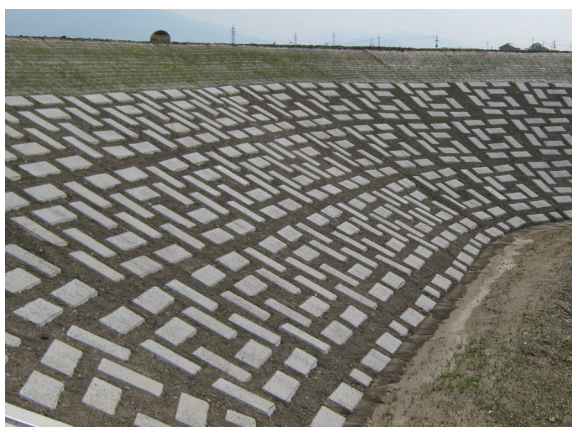
徳島県 新明池 コンクリート標準タイプ200型
