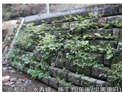
京都府 水呑線 施工10年後(災害復旧)
