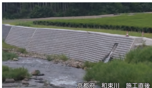
京都府 和束川 施工直後
