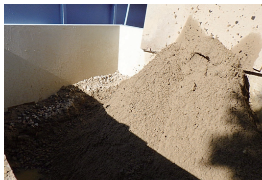
写真－8 破碎された巨石片を含む排土
