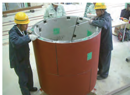
水平仮組検査
