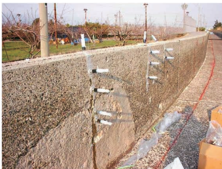
写真－ 4.21 ひび割れ注入の状況
