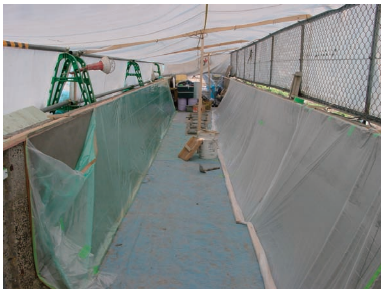
写真－ 4.33 シート養生状況
