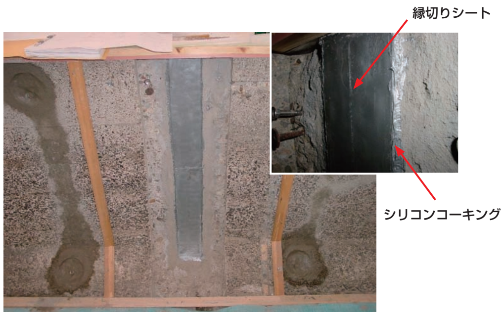
写真－ 4.27 無付着区間設置完了状況
