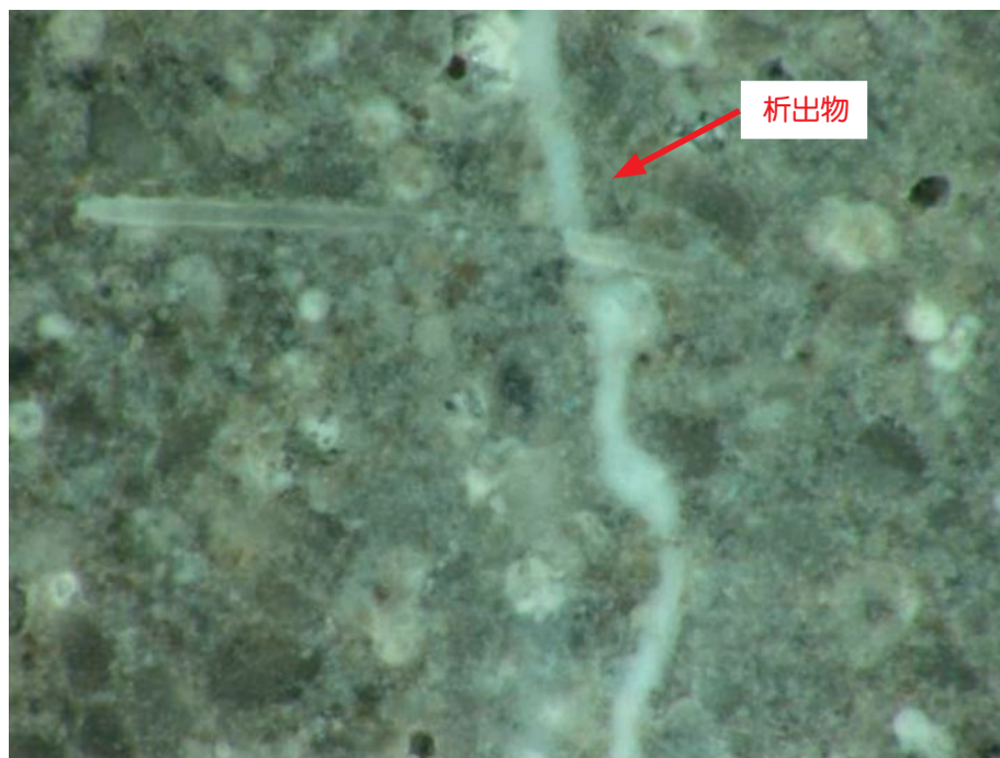
写真－3.1 ひび割れの自己治癒の状況
