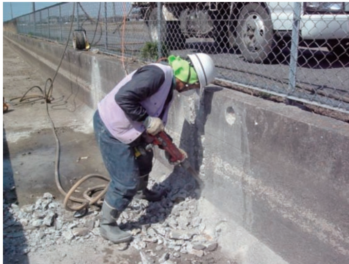
写真－ 4.15 はつり状況
