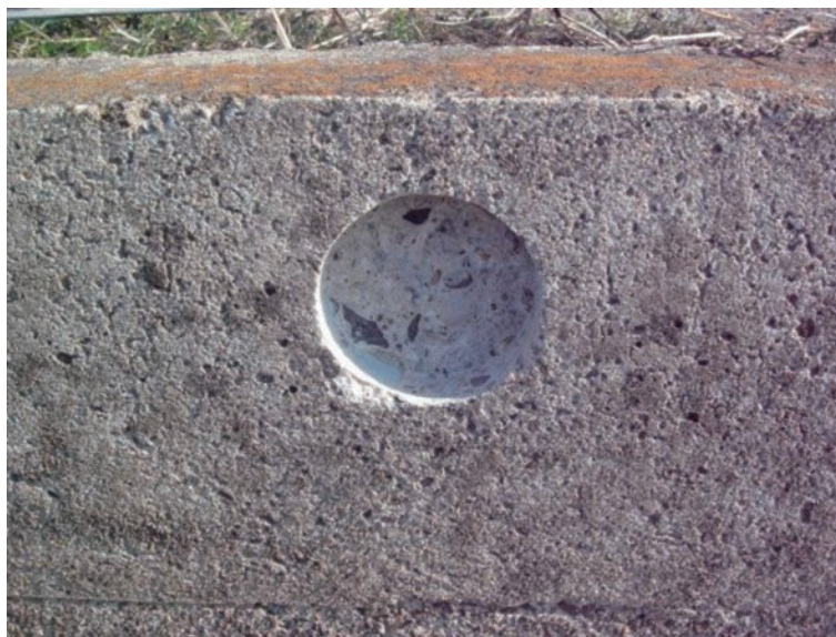
写真－4.18 孔明け完了状況
