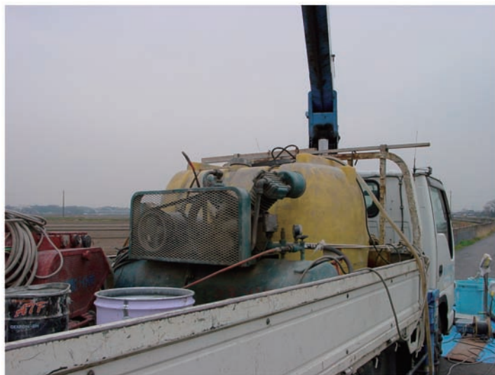
写真－ 4.28 吹付けプラント設置状況一例
