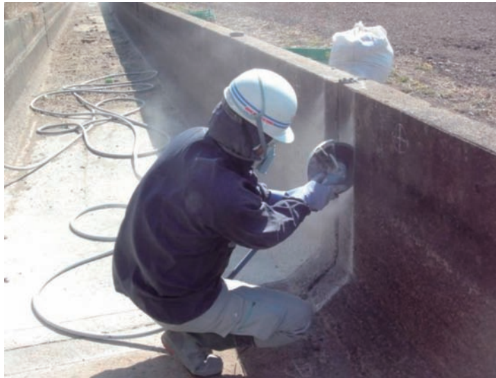
写真－ 4.14 コンクリートカッター切込み状況
