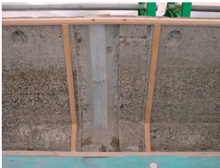
写真－ 4.24 側面 型枠設置完了状況 2
