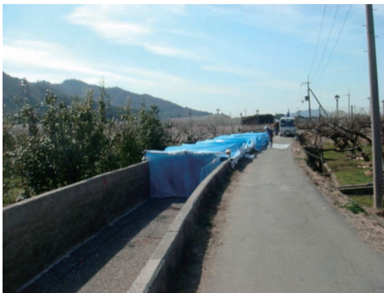
写真－4.13 養生状況
