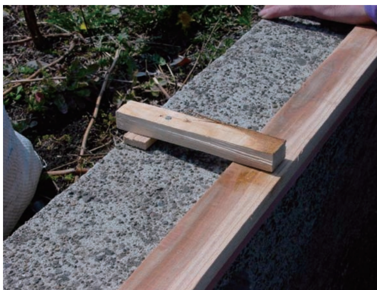
写真－ 4.23 天端 型枠設置完了状況
