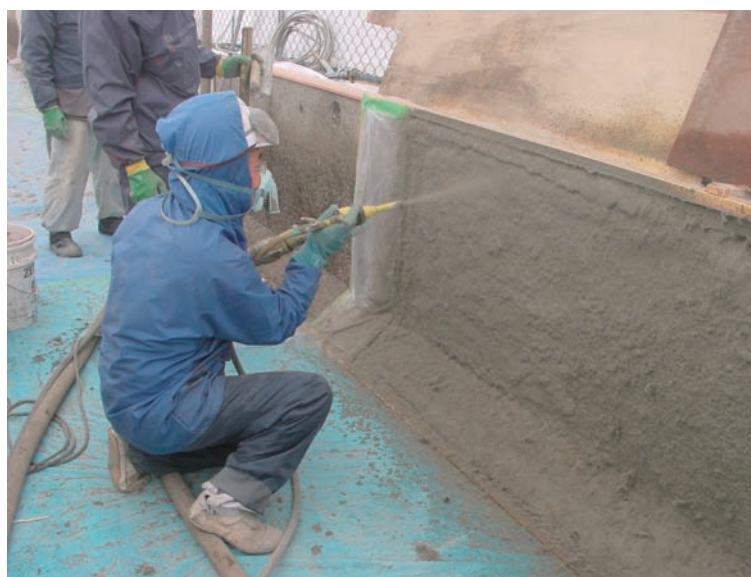
写真－ 4.30 吹付け状況
