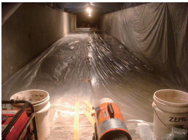
写真－ 4.34 給熱養生状況
