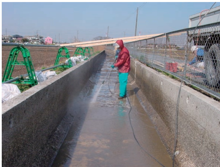
写真－ 4.20 表面洗浄状況
