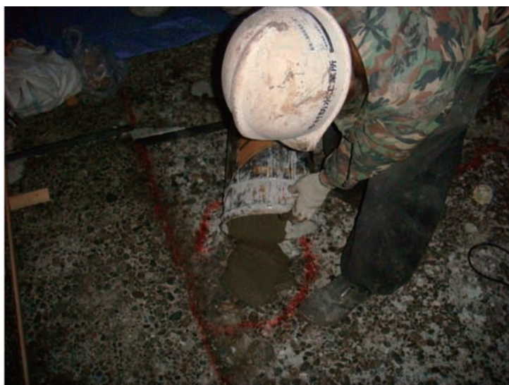
写真－ 4.22 断面修復の状況
