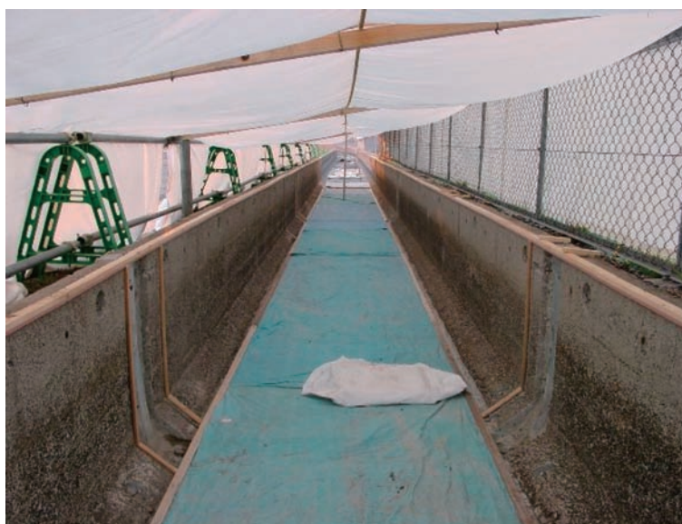
写真－ 4.25 底面 型枠設置完了状況
