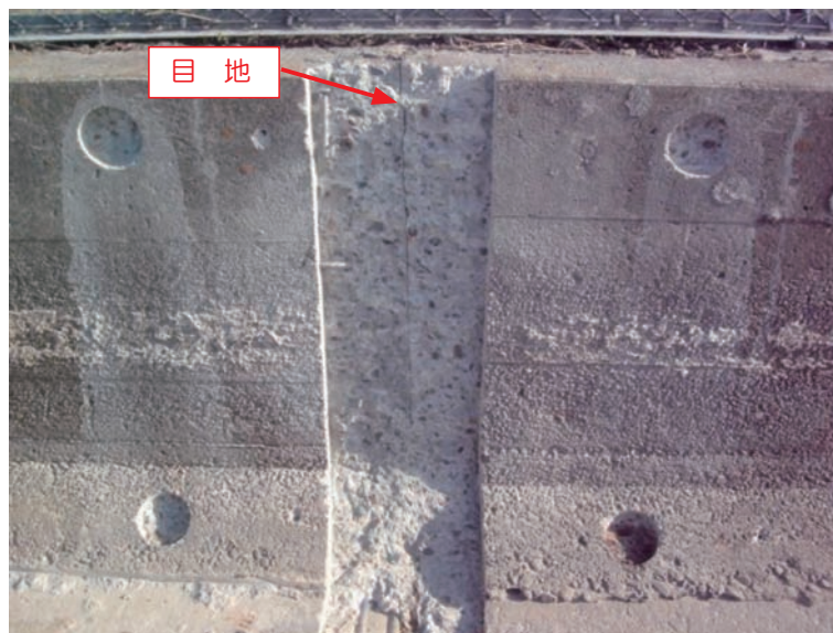
写真－ 4.16 目地部はつり完了の全体状況
