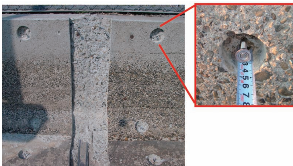
写真－4.19 アンカー設置完了状況
