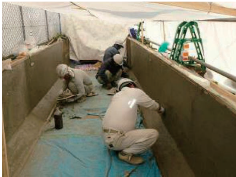
写真－ 4.32 仕上げ状況
