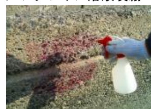
呈色あり（施工後）
