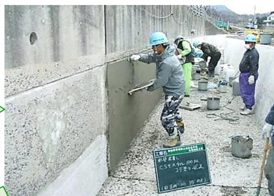
④：CSモルタルコテ塗り
