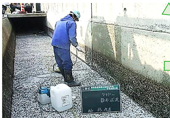
③：CSクリアー（1回目-躯体面）
