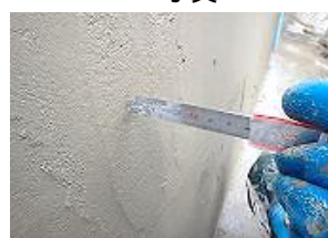
被覆厚さ測定（硬化前）
