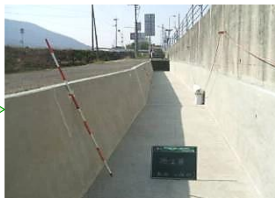
⑥：施工完了
