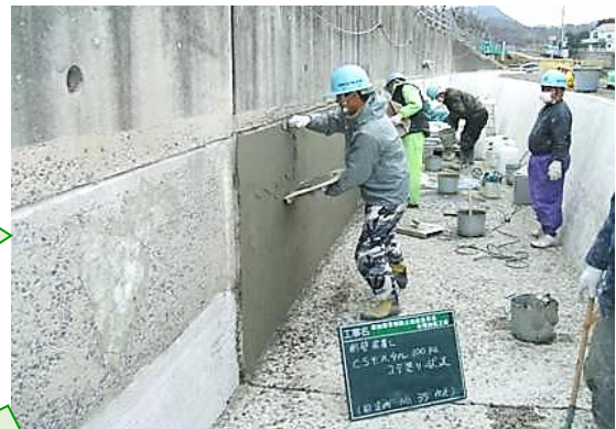
④：CSモルタルコテ塗り
