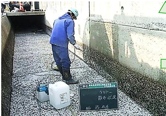
③：CSクリアー（1回目-躯体面）
