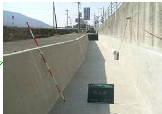
⑥：施工完了
