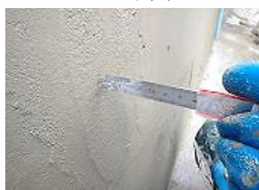
被覆厚さ測定（硬化前）
