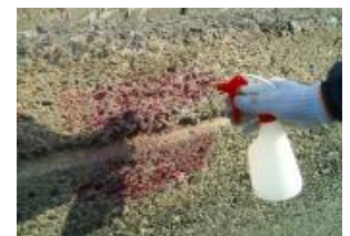
呈色あり（施工後）
